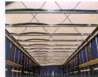
Dieses Dach ist durch Drahtseile verstärkt.
